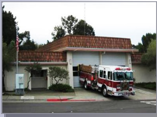
San Mateo Station 27—1801 DeAnza Blvd. Engine 27—3 personnel; Engine E327 & OES 291
